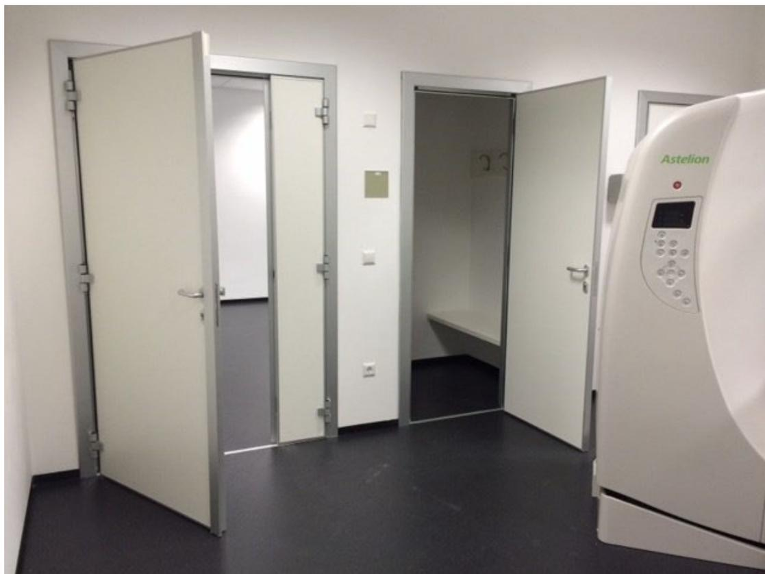
Anta costruita in tamburato di legno duro, con interposta lamina di piombo di prima fusione, titolo 99,9%, calibrata e spazzolata.
